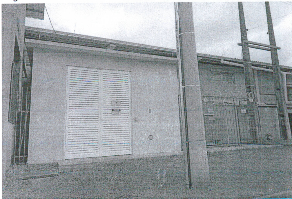
Nova Subestação instalada 2025
